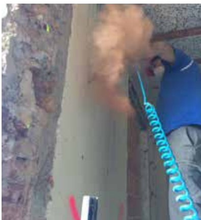
Pulizia con aria compressa
