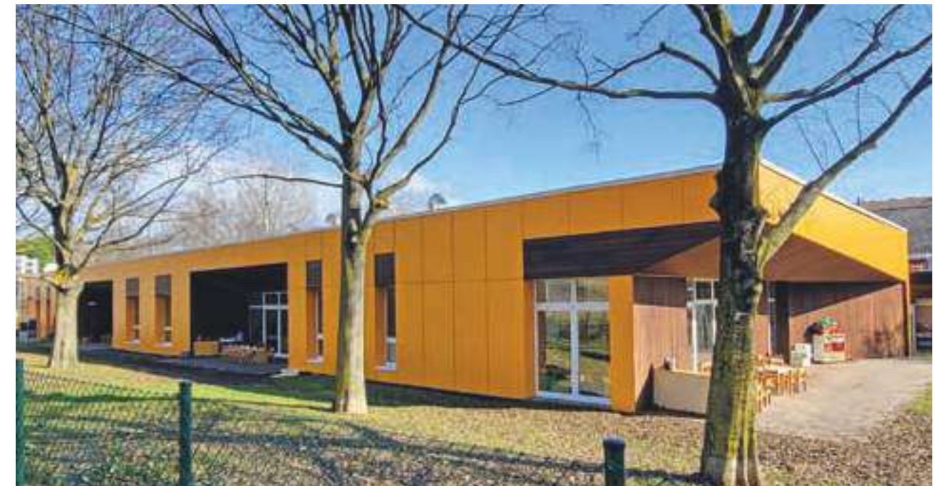
BOLOGNA Realizzazione della facciata ventilata di una scuola materna in HPL con fissaggio a scomparsa.
