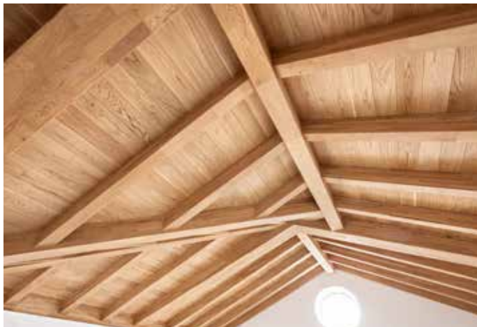
Casa privata | Tetto in legno lamellare di rovere
