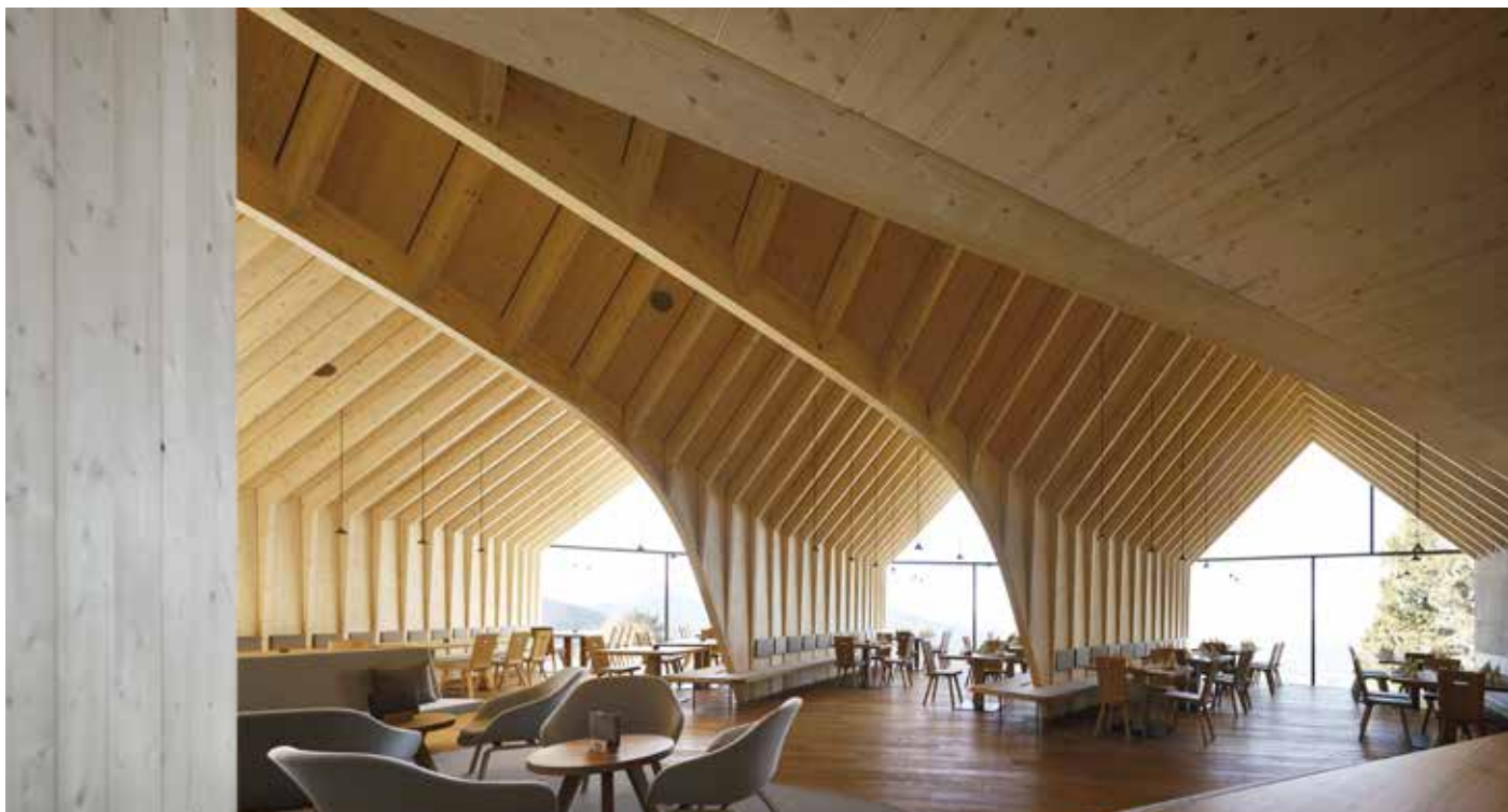
Rifugio – Ristorante Oberholz | Struttura in legno lamellare di abete
