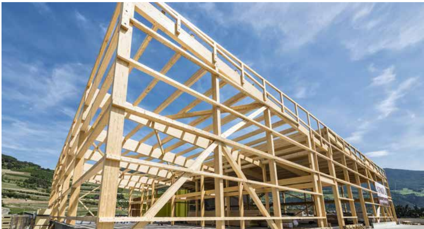
Capannone industriale, sopraelevazione | Legno lamellare di abete industriale
