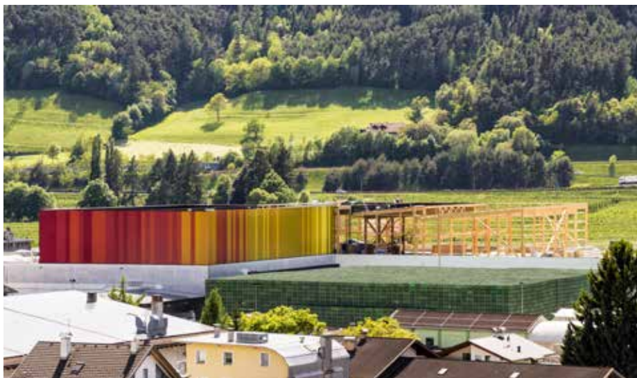
Capannone industriale, sopraelevazione | Legno lamellare di abete industriale
