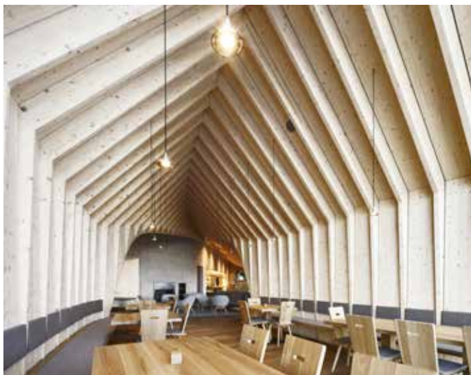
Rifugio – Ristorante Oberholz | Struttura in legno lamellare di abete
