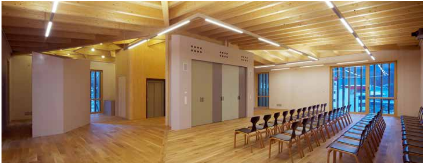
Struttura aziendale | Tetto in legno lamellare di abete
